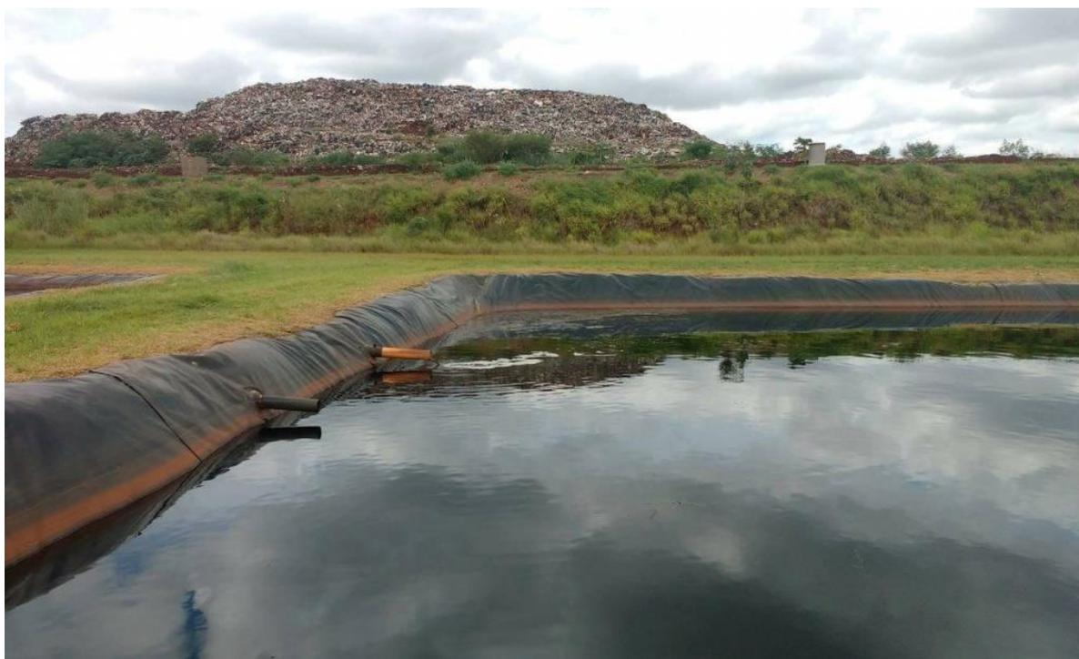
**Figura 7:** Lagoa anaeróbia de captação de Chorume através dos drenos. (Aterro Sanitário Municipal de Dourados-MS)
