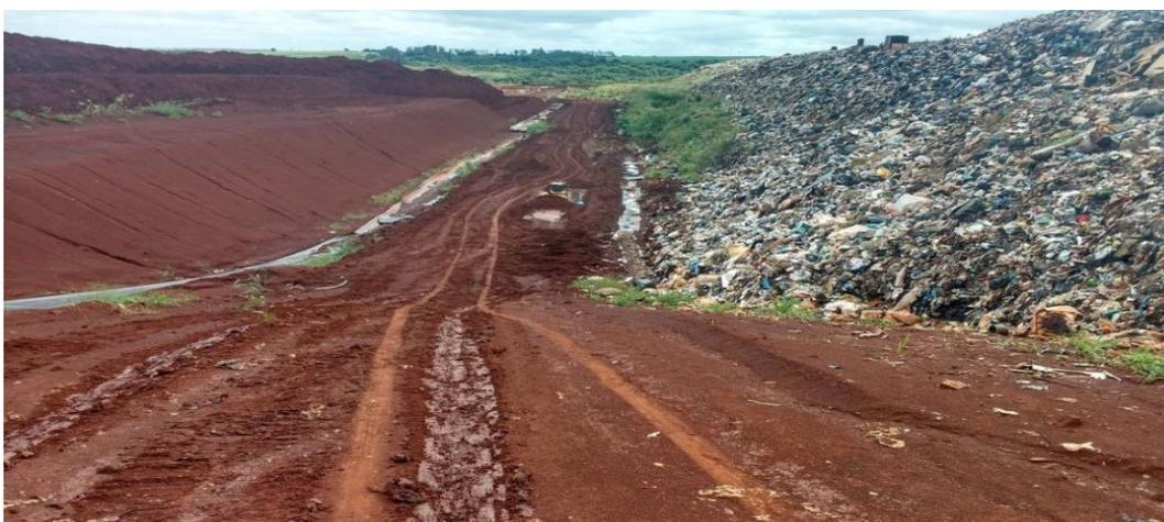
**Figura 6:** Solo compactado para o aterro dos Resíduos (RSU) do Aterro Sanitário Municipal de Dourados-MS. Fonte: SECCATTO, 2017.
