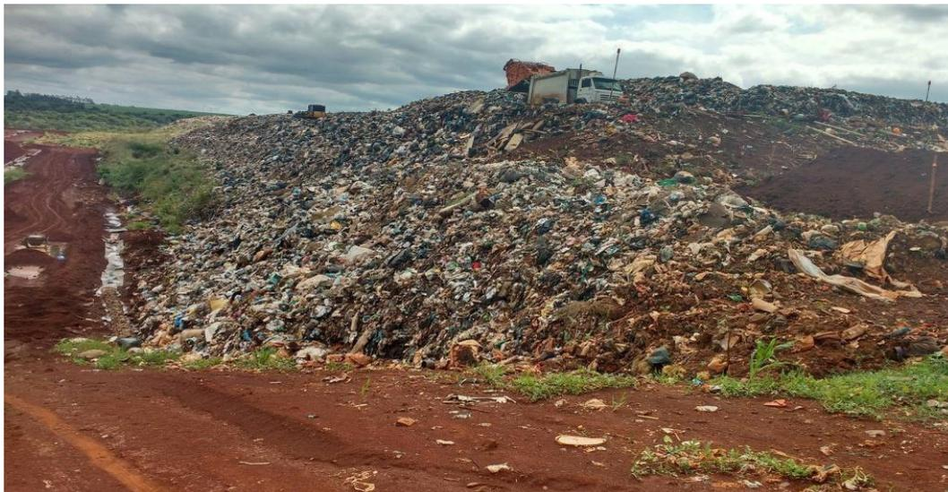
**Figura 5:** Operação de espalhamento de Resíduos sólidos (RSU) do Aterro Sanitário Municipal de Dourados MS.
